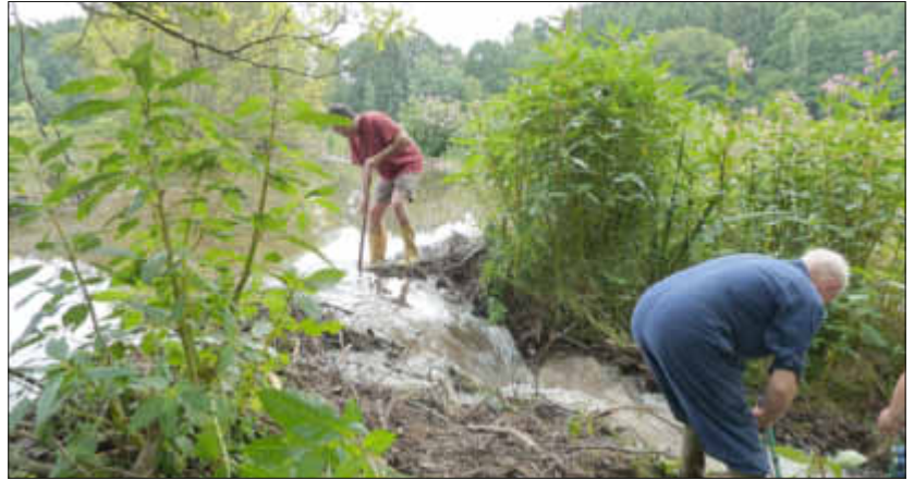
zuerst muss der Wasserspiegel gesenkt werden
