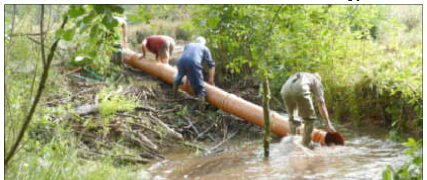
das vorbereitete Rohr soll den Wasserspiegel dauerhaft senken
