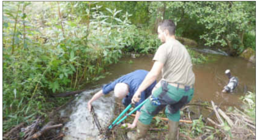
Vorbereitung für das Rohr
