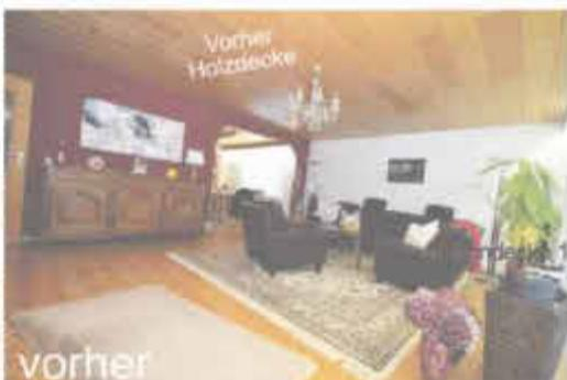
Vorher: Wohnzimmer mit Streifenplatten in Holzoptik. Die Decken waren gut erhalten und konnten somit als Unterkonstruktion wiederverwendet werden.
