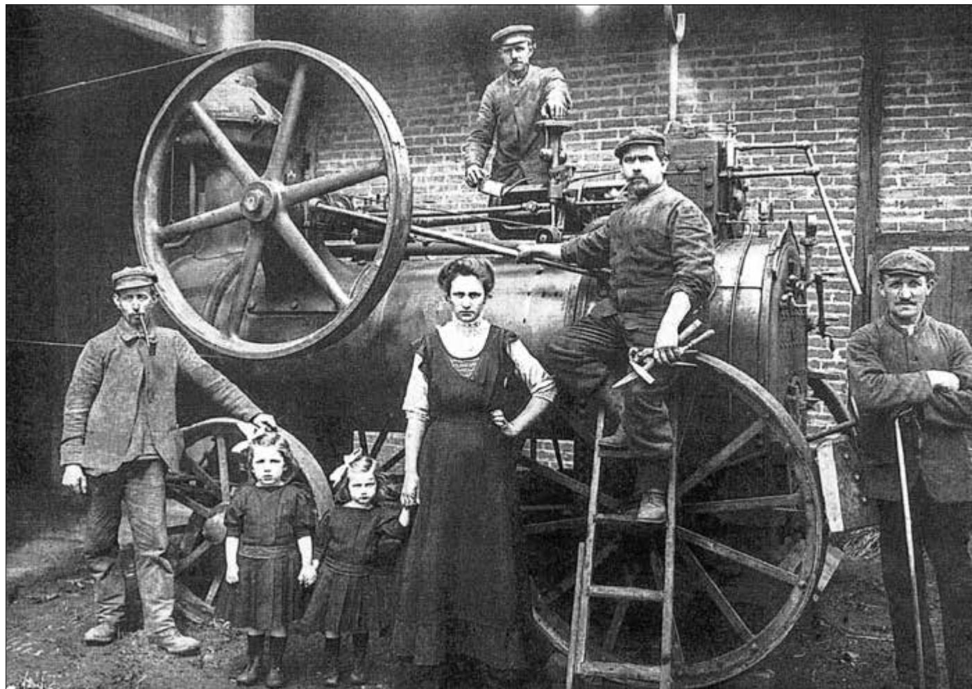
Eines von insgesamt dreizehn Kalendermotiven zeigt die erste Dampfmaschine in Losheim, die von Monteur Jakob Lauer (auf der Leiter) bedient wird. Foto: Archivbild des Losheimer Heimatvereins
