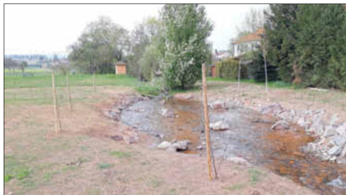
Renaturierungsmaßnahme am Losheimer Bach: links: oberhalb der Ortslage während der Arbeiten, rechts: Freifläche in der Unteren Haagstraße mit Ufervegetation nach den Arbeiten. Fotos: T. Kreuz
